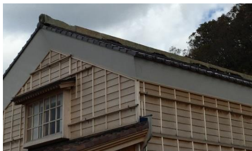
歌楽にある橋本家土蔵の棟石に 使われている笏谷石
