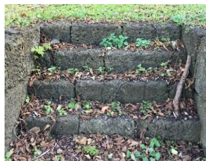
寿都石（仮）と思われる 有戸佐藤家の敷地内の階段
