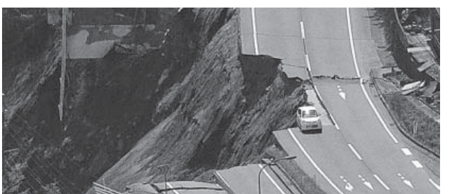
4月14日に発生した熊本地震で崩れ落ちた道路
