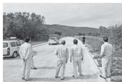
矢追新通り線新設工事
