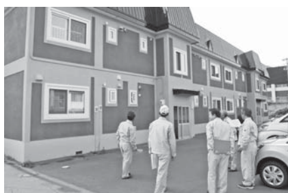
陣屋団地（G棟）改修工事
